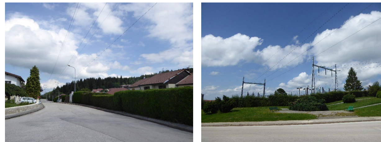
A gauche : ligne électrique passant au-dessus d'habitations. A droite : transformateur à Pontarlier
