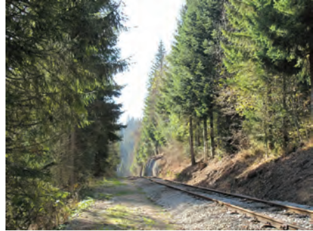
5 à 7. Voie ferrée
