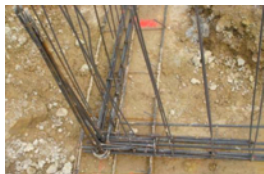
Noeud de chaînage - Continuité mécanique
