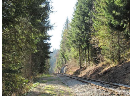
5 à 7. Voie ferrée
