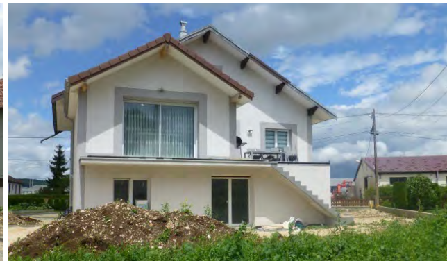
Vue arrière de la maison
