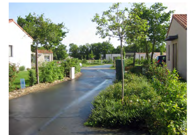
Voie tertiaire-voie partagée (voitures, piétons, vélos) à sens unique Treize-Septiers (85) - La Papinière
