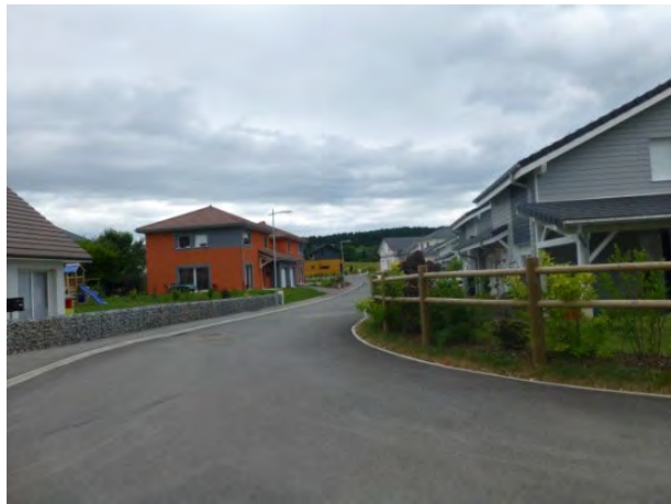
Gabions et barrières de bois, Ste-Colombe
