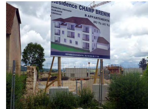
Démolition/reconstruction (relique du mur), Houtaud
