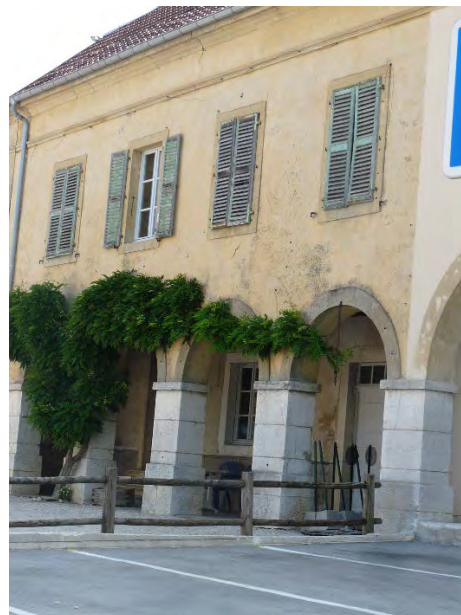
Immeuble avec galeries, Doubs
