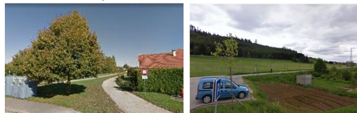
Voie verte aménagée à Doubs
