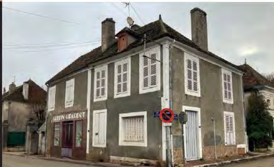
Châtel-Censoir, acquisition maison en centre-bourg, Source : EPF Doubs BFC
